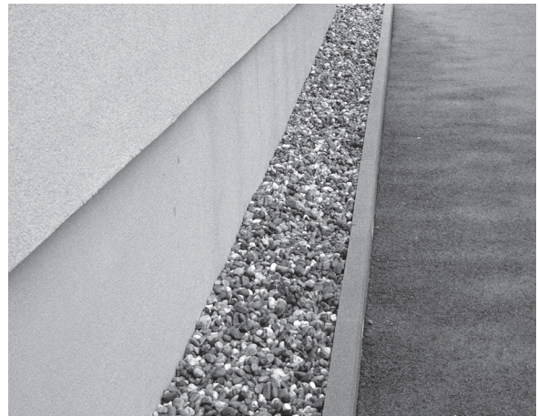
4 pav. Coklio tinkuota sudėtinė termoizoliacinė sistema, esanti prie vėdinamos ir drenuojamos nuogrindos po 10 metų.
