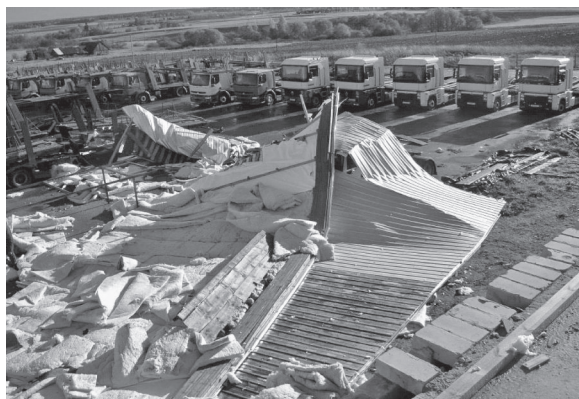
39 pav. Vėtros suardytas nepatikimai sutvirtintas šlaitinis stogas.
