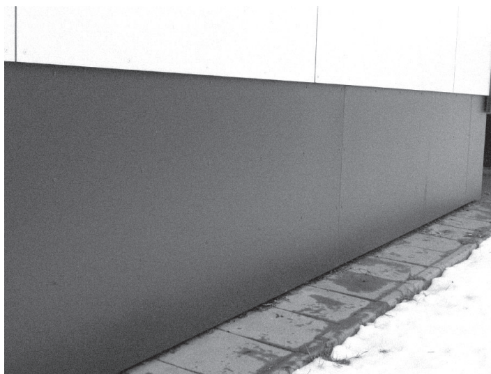
9 pav. Cokolio, apšiltinto vėdinama termoizoliacine sistema, fragmentas.
