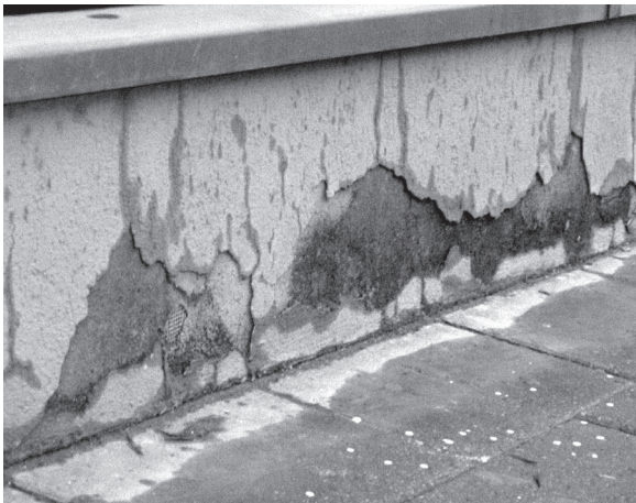
3 pav. Gendanti coklio gendanti tinkuota sudėtinė termoizoliacinė sistema, esanti prie uždaros nuogrindos po 3 metų.
