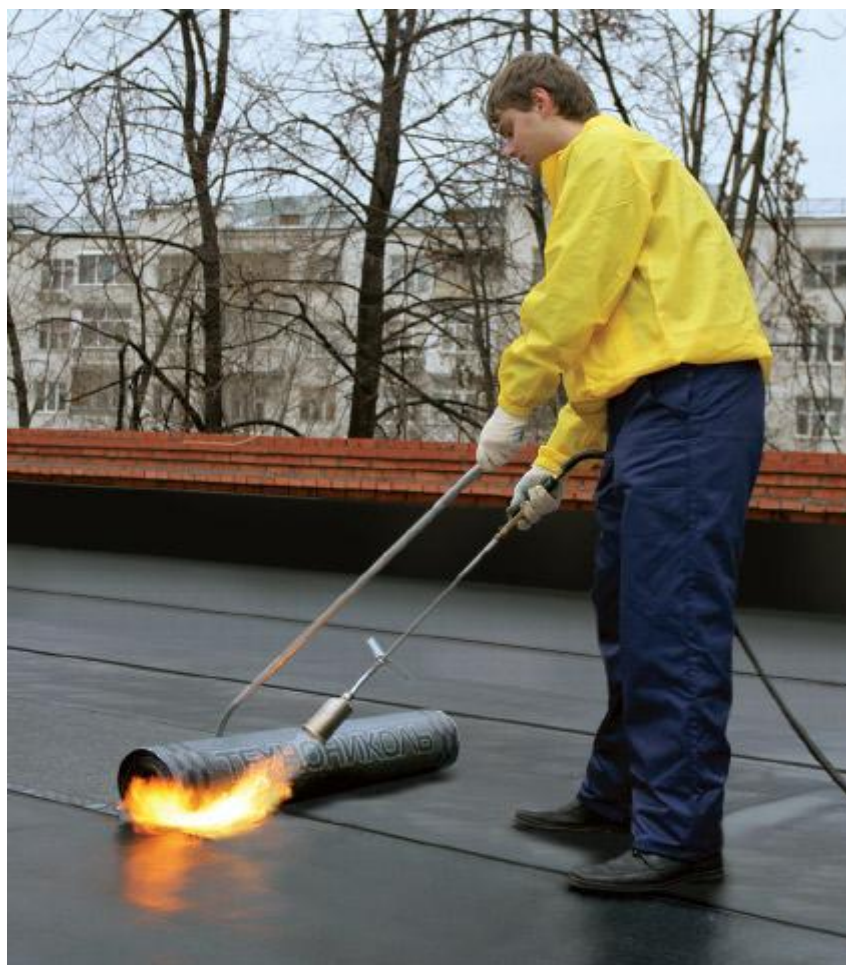
34 pav. Stogdengio padėtis dengiant stogą.
