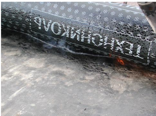
36 pav. Ištirpintos polimerinės - bituminės masės „banga“
